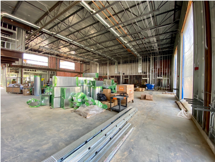
Commons & Servery Photo / April, 2020
