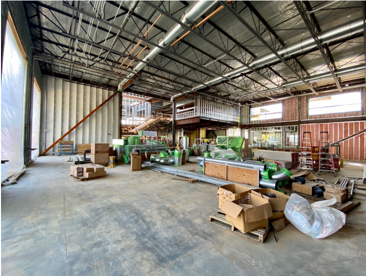
Commons & Stair Photo / April, 2020
